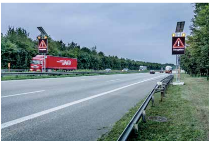
Bild 1: Mobile LED-Stauwarnanlagen entschärfen den Verkehrsfluss in Baustellenbereichen (Foto: Ibotech)
