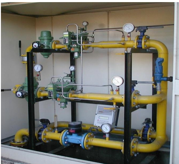
Druckregel- und Messtation für Erdgas
