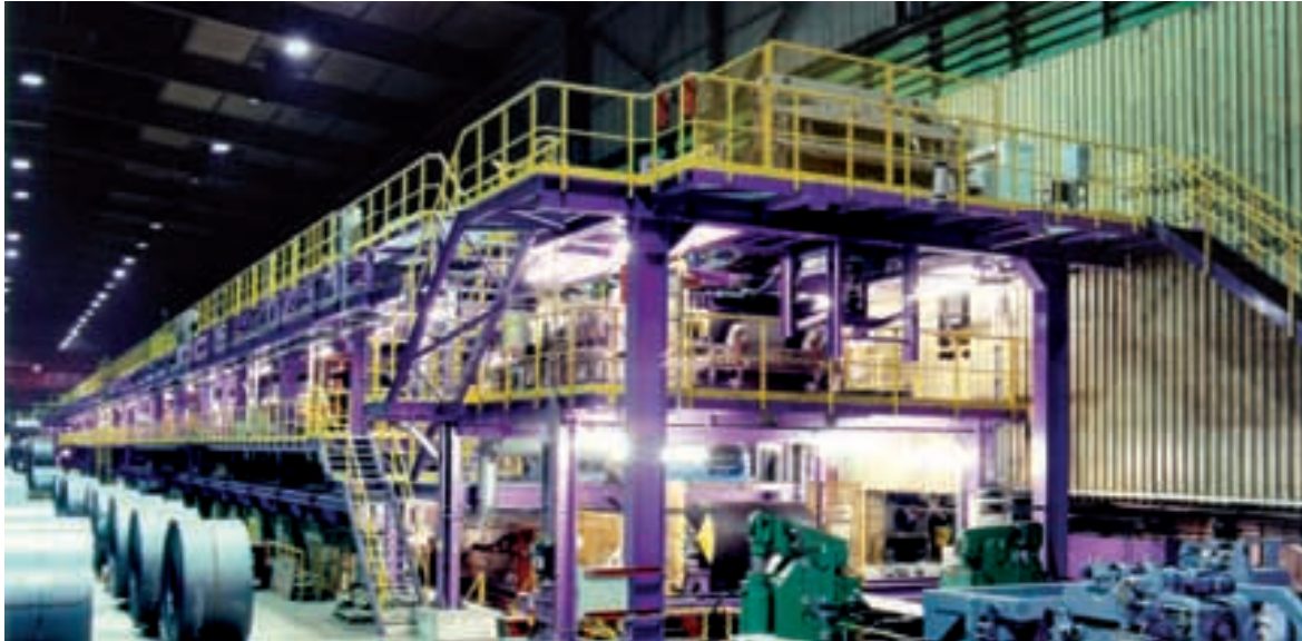
Example of Siemens VAI coupled pickling line
